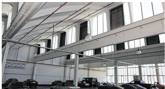
Anmutige Shed-Dachkonstruktion: Die senkrecht stehenden Fenster hat Architekt Rudolf Loders durch gekrümmte Stahlbetonelemente miteinander verknüpft.
